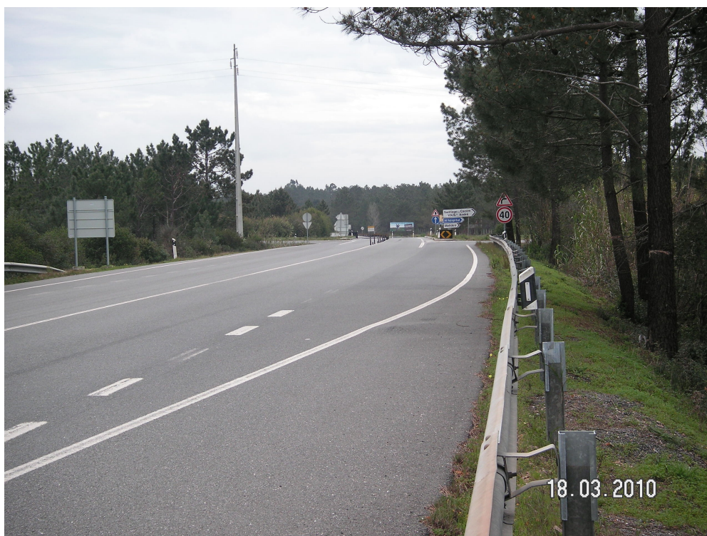
Foto 1.1 – Aspecto geral do IC33 na zona do nó da Badoca
